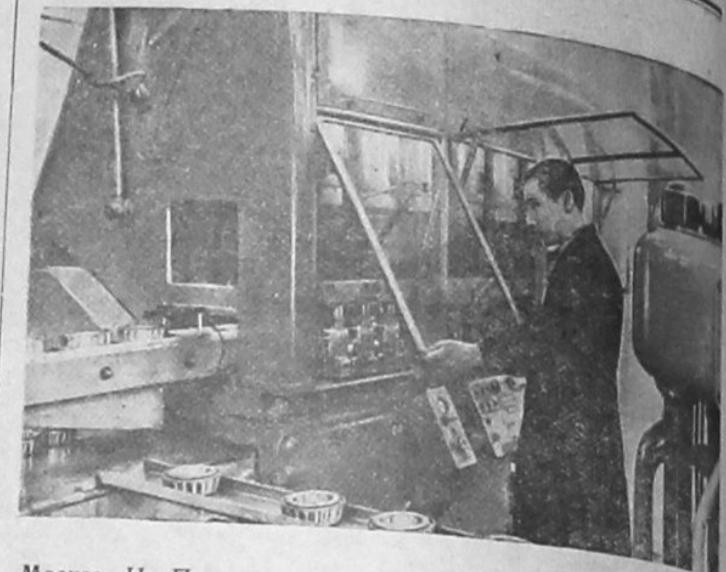
Москва. На Первом подшипниковом заводе имени Л. М. Кагановича технические комиссии принимают в эксплуатацию автоматическую линию цеха массовых подшипников. Токарный участок этой линии уже вступил в строй, закончен испытание термического оборудования, готовится к пуску самые крупные участки — шлифовальный и сборочный.
